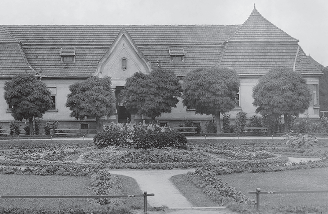
Centralne rondo i budynek XIV (siedziba administracji i izba przyjęć), ok. 1930
